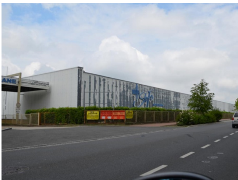
Abbildung 18: Brache der ehemaligen Textilwerke Drews
