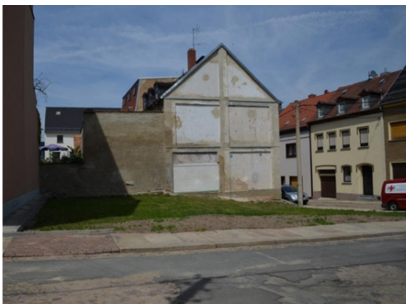
Abbildung 14: Eine erfasste Baulücke der Stadt Meerane auf der Emilienstraße
