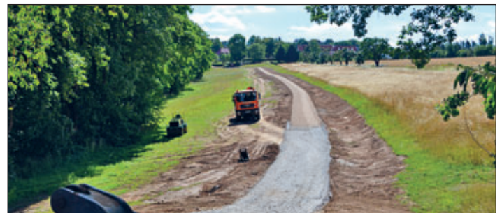
Der neue Geh- und Radweg aus Richtung Parkplatz Nelkenweg. Das Foto zeigt die Arbeiten am 12. Juli 2022. Fotos: Hönsch
