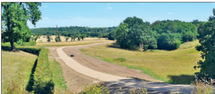
Der neue Geh und Radweg verbindet die Schwanefelder Straße mit dem Parkplatz Nelkenweg und im weiteren Verlauf mit dem Meeraner Meerchenwald (Foto vom 28. Juli 2022).
