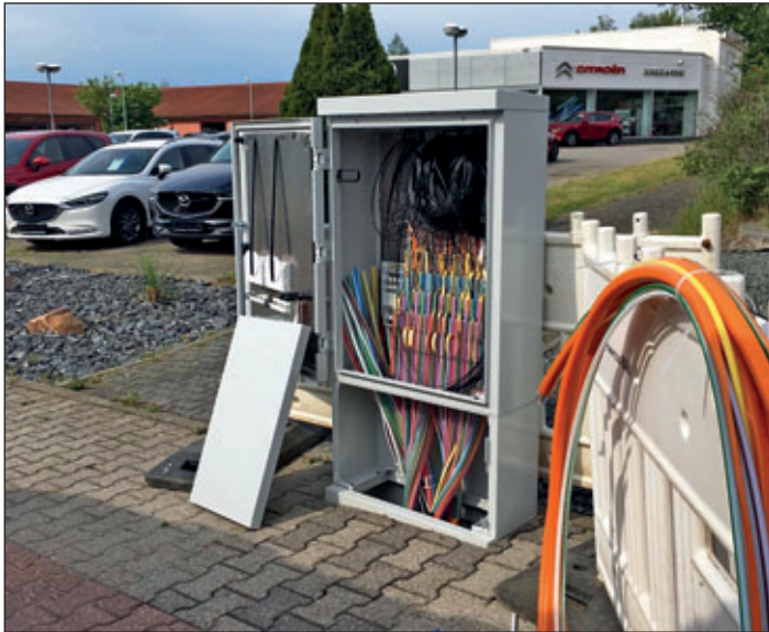
Ein Kabelverzweiger in der Seiferitzer Allee im Juni 2020, von hier werden die Glasfasern an die einzelnen Hausanschlüsse verteilt.
