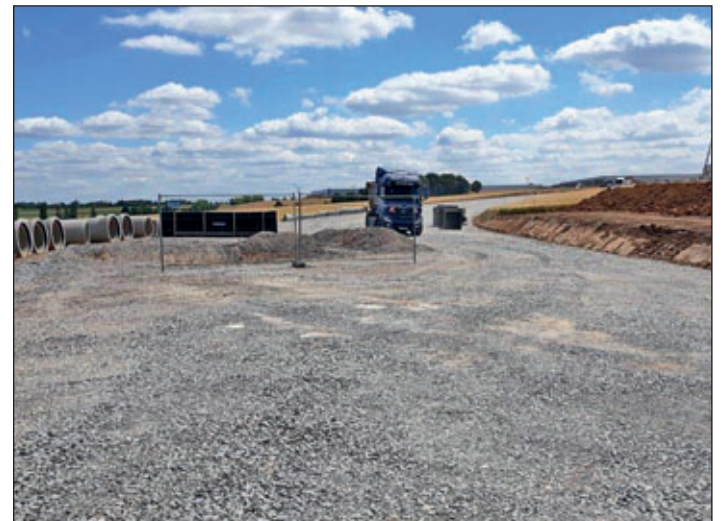
Anfang Juli 2019 war der neue Trassenverlauf bereits sichtbar. Foto: privat
