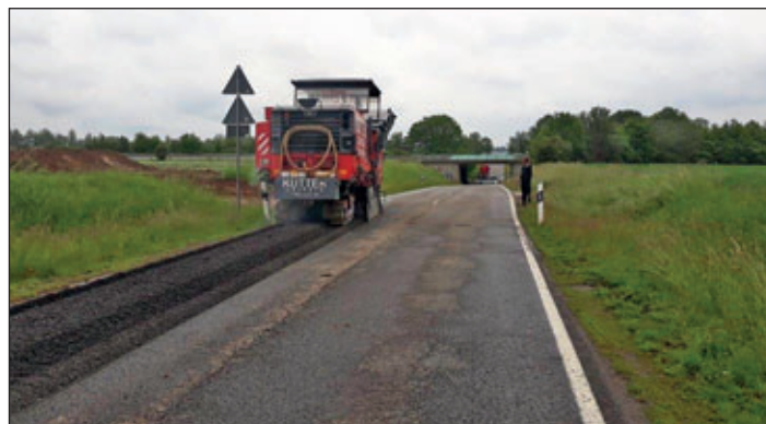
Baubeginn für die neue S 288 am 28. Mai 2019. Foto: privat
