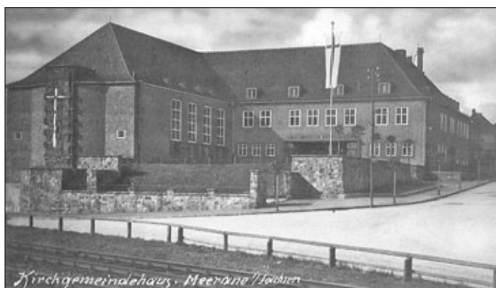
Historische Ansicht des Kirchgemeindehauses in der Kantstraße, erbaut 1928–1930.
